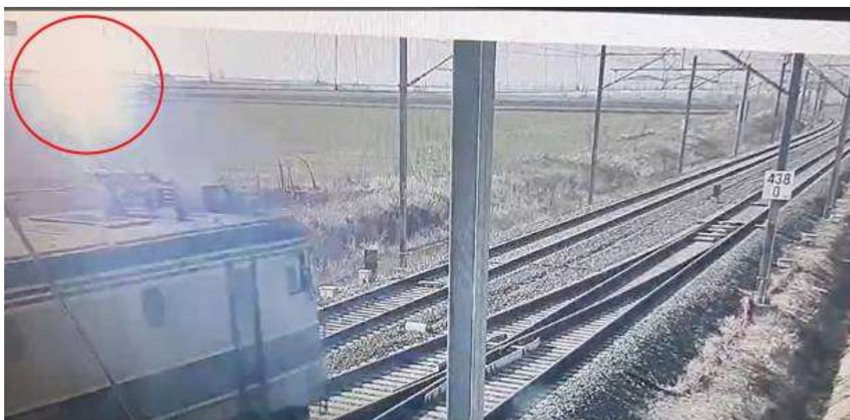
Foto nr.13. Momentul de după atingerea pantografului nr.2 (primul sens mers) de la EA 048 a scurtcircuitului LC
