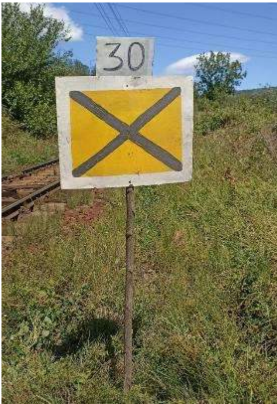
Foto nr.1 Paletă restricție de viteză Post Macazuri
