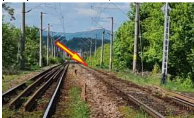
Imaginea nr.2 –șinele fuseseră scoase din cale de pe firul II închis pentru circulație
