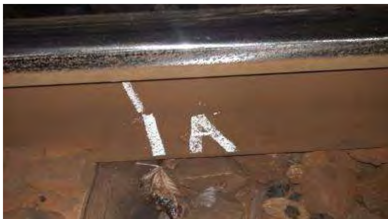
Foto nr.3: Urmă de escaladare a unei roți pe flancul activ al șinei, punctul "A"
