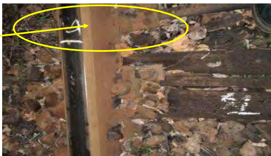
Foto nr.5: Dispozitiv improvizat pentru menținerea ecartamentului(tirant).
