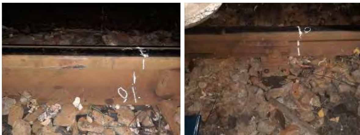
Foto nr.2: Prima urmă de deraiere la km. 25+333 punct "0" (fir stâng /fir drept).
