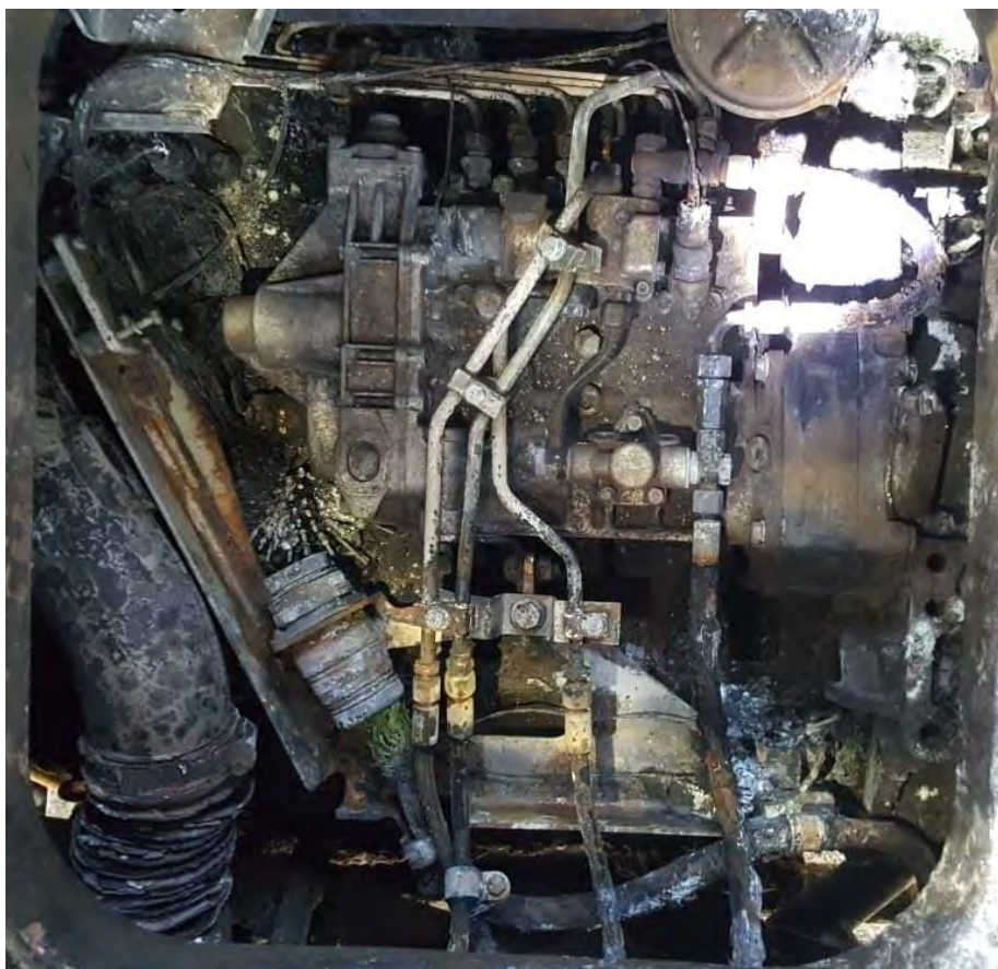
Foto nr.1 – Depuneri de praf, resturi vegetale și produse petroliere depuse pe partea superioară a grupului power-pack, observate prin capacul superior de vizitare, imediat după stingerea incendiului.
