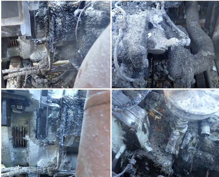
Foto nr.2 – Diverse zone ale grupului power-pack cu depuneri mari de praf, resturi vegetale și produse petroliere, observate după demontare de sub cutia automotorului Desiro nr.2084.
