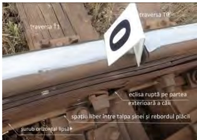
Foto nr.10 – eclisa ruptă în exteriorul căii
