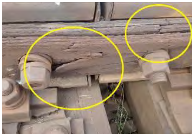
Foto nr.11 – eclisă ruptă în exteriorul căii
