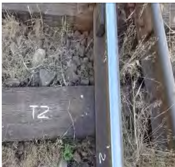
Foto nr.12 – lipsă placă metalică la traversa T2
