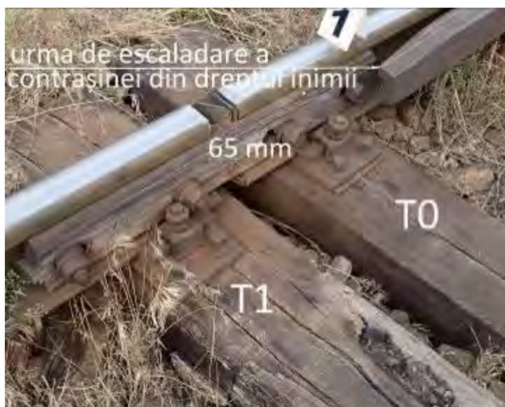
Foto nr.13 – joanta de capăt a schimbătorului de cale nr.8, din partea stângă a sensului de mers
