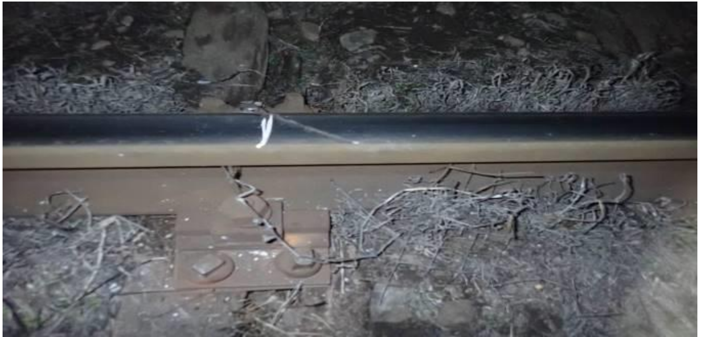
foto nr.13: zona escaladării roții stângi a celei de-a 2-a osii o șinei din partea sa dreaptă
