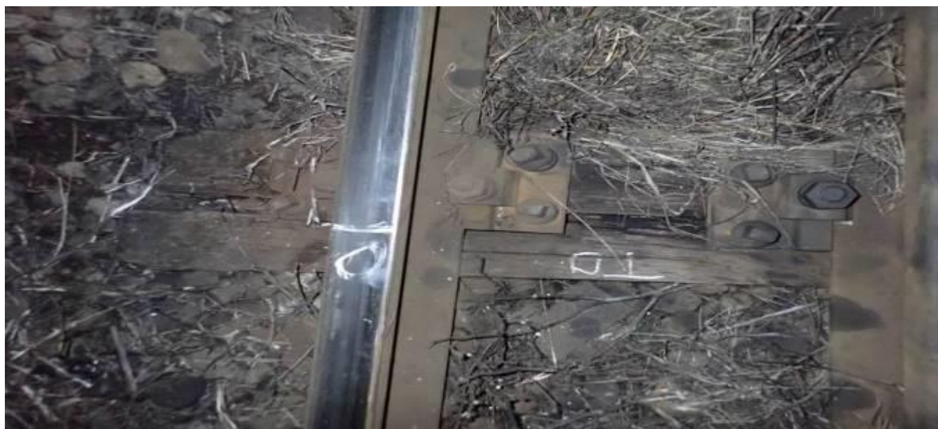
foto nr.12: zona punctului 0
