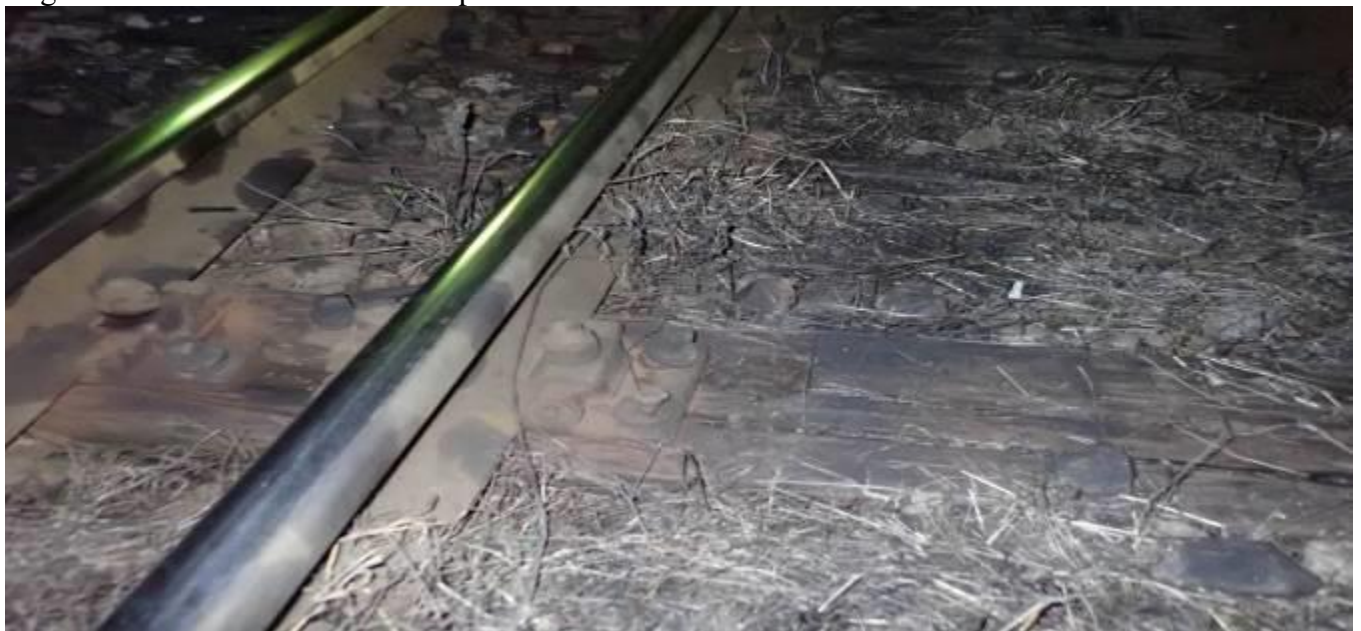
foto nr.2: starea prisme de piatră spartă pe zona producerii accidentului
