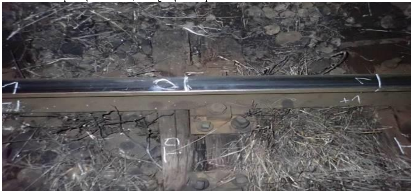
foto nr.11: prisma de piatră spartă în zona punctului 0
