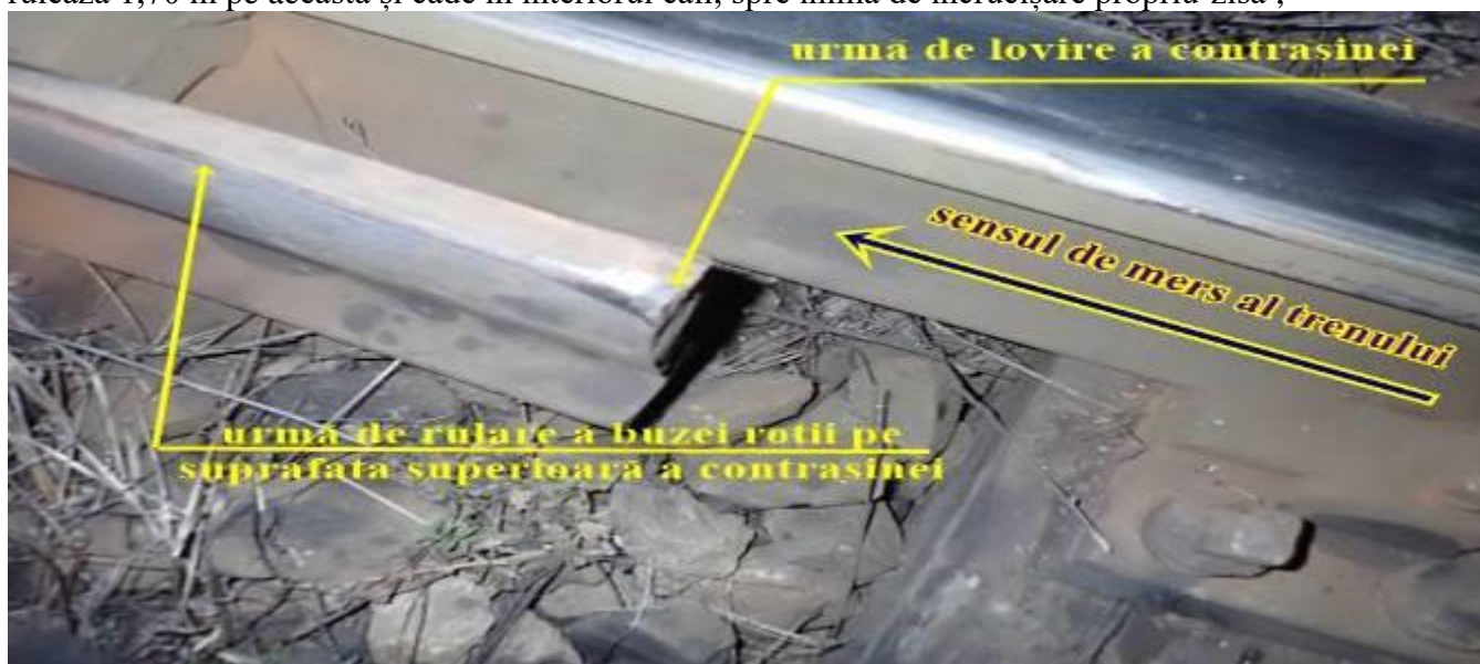
foto nr.4: lovitura aplicată contrașinei de către roata din partea dreaptă
