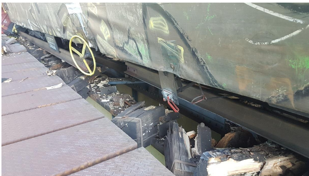
foto nr.5 - capete de traverse rupte
