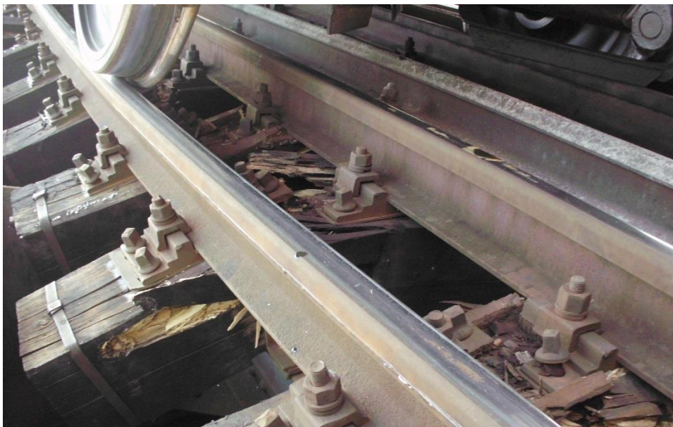
foto nr. 11 - capete de traverse de lemn speciale pentru poduri rupte, dar cu prinderi active
