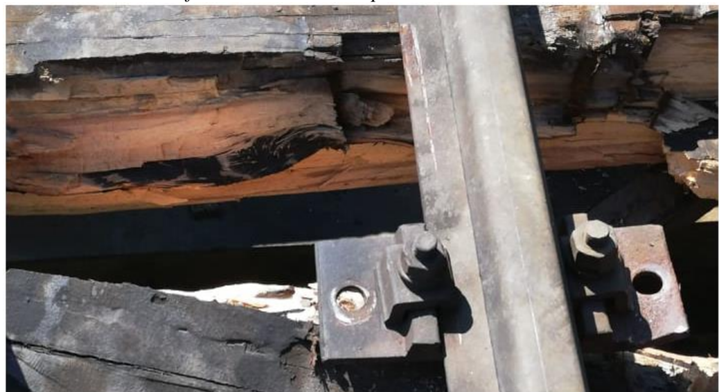
foto nr. 7 - traversă care la interior are aspect de lemn carbonizat
