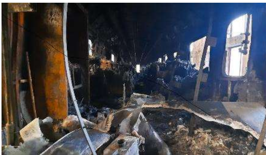
Imaginea nr.9 – interiorul vagonului afectat de incendiu
