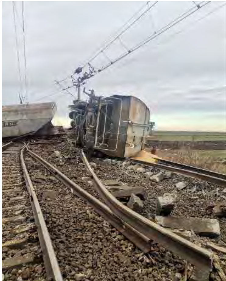
Foto nr.9. Diagonala 2/4 afectată de deraiere
