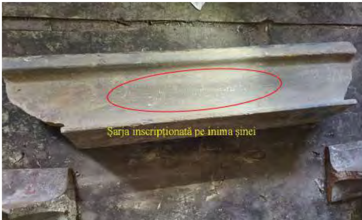
Foto nr.15. Șarja inscripționată pe inima șinei cu rupere multiplă
