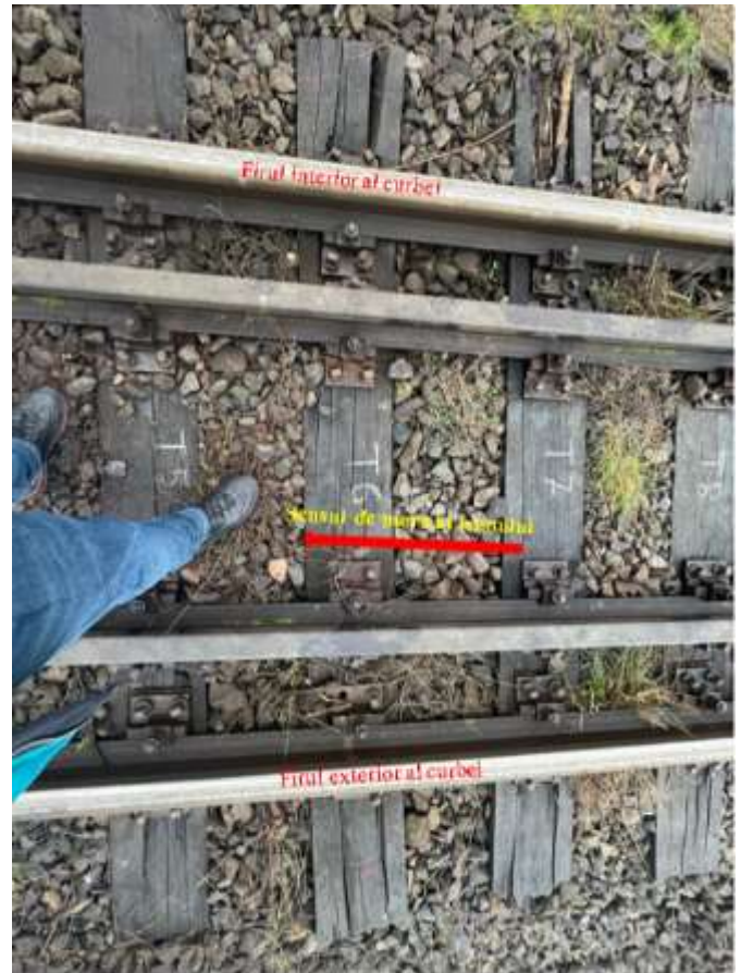
Foto nr.12 - Starea tehnică a traverselor T_5 , T_6 și T_7
