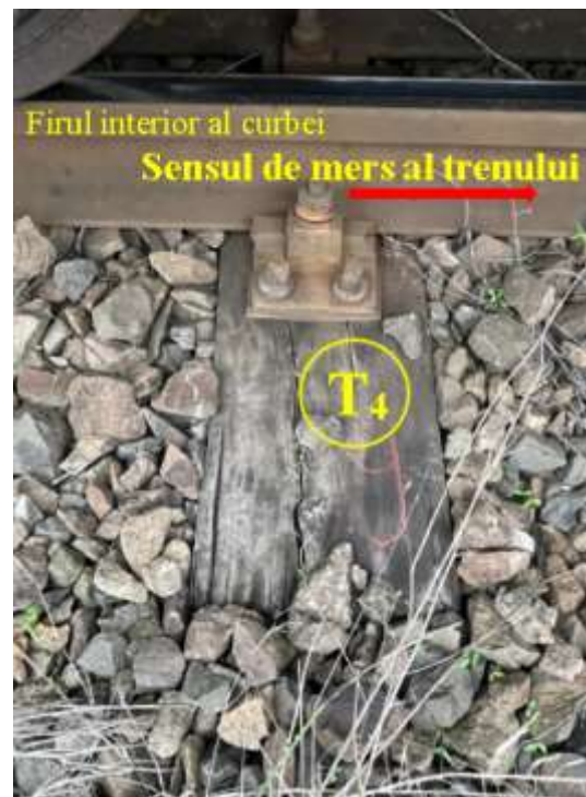
Foto nr.24 - Capătul traversei T 4 pe firul interior
