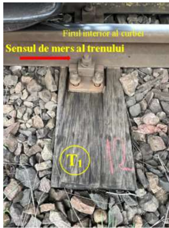
Foto nr.18 - Capătul traversei T 1 pe firul interior
