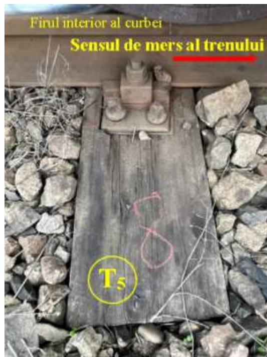
Foto nr.26 - Capătul traversei T 5 pe firul interior
