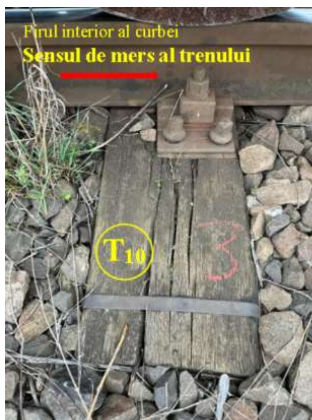
Foto nr.36 - Capătul traversei T 10 pe firul interior
