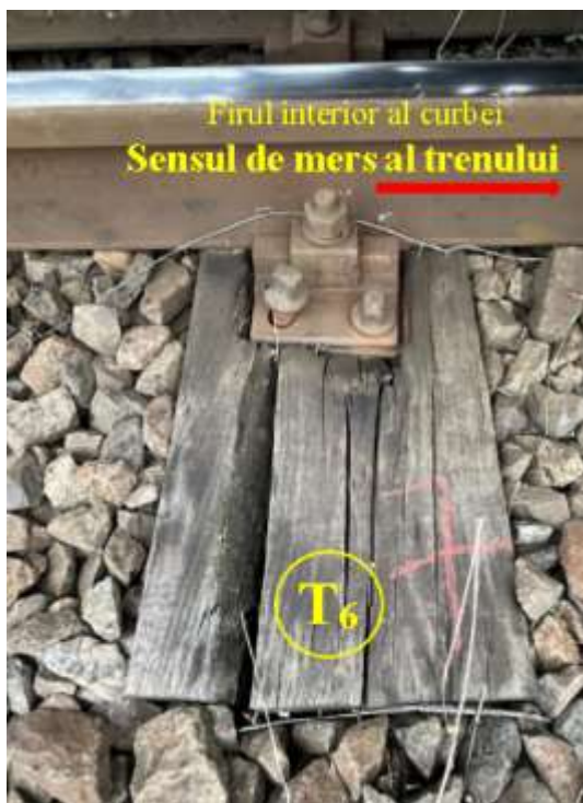
Foto nr.28 - Capătul traversei T 6 pe firul interior
