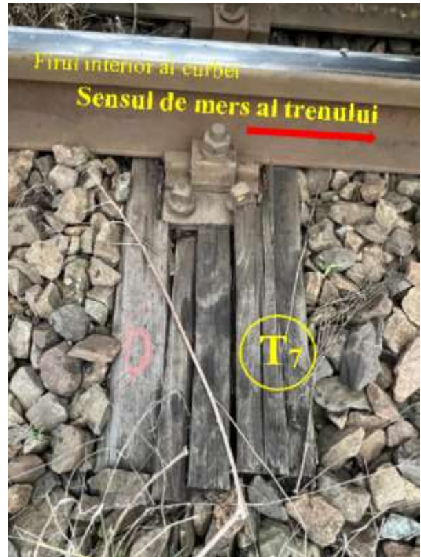
Foto nr.30 - Capătul traversei T 7 pe firul interior
