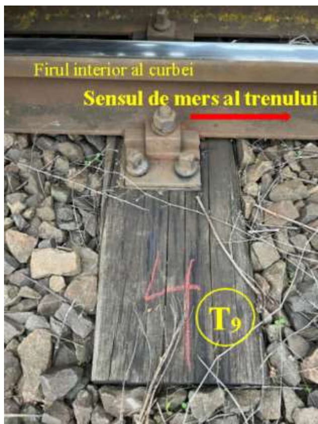
Foto nr.34 - Capătul traversei T 9 pe firul interior
