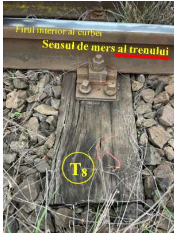
Foto nr.32 - Capătul traversei T 8 pe firul interior
