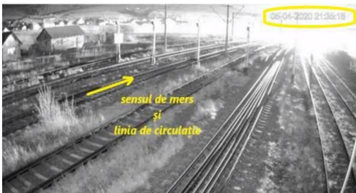
Foto nr.2 – momentul declanșării arcului electric (descărcarea luminoasă) – captură foto după imagini filmate de una din camerele de luat vederi din Hm Augustin
