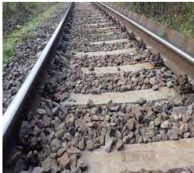
Foto nr.16 – Prindere completă și activă
