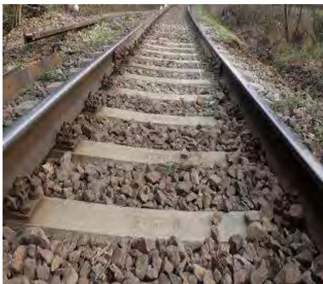
Foto nr.15 – Prindere completă și activă
