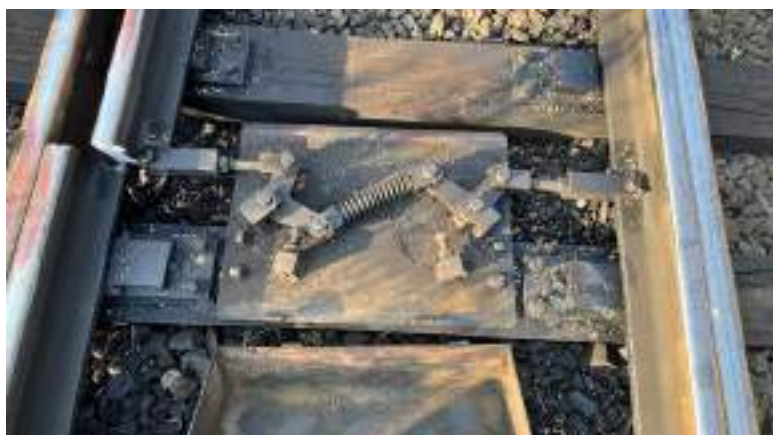
Foto nr.16 – Starea dispozitivului ajutător de manevrare cu arc Fig. nr.4 – Figura din IL 302 4.4
