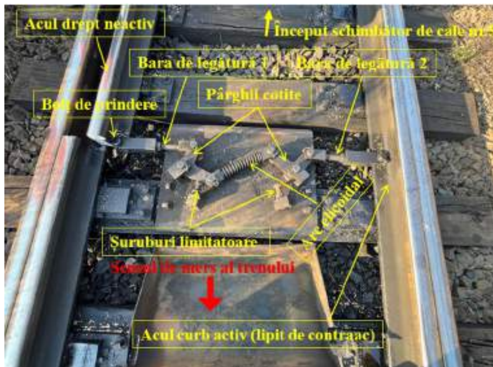
Foto nr.15 – Părțile componente ale dispozitivului ajutător de manevrare cu arc
