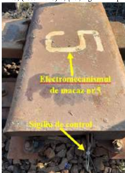
Foto nr.18 - Electromecanismul de macaz nr.5
