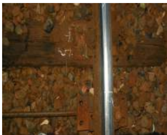
Foto.nr.6 - Traversa T 5
