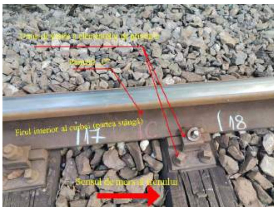
Foto. nr.4 – Punctul „C”: urmă de cădere între firele căii
