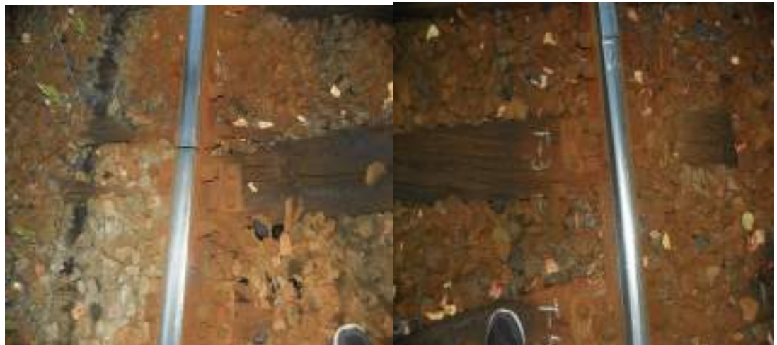
Foto.nr.10 - Traversa T_3
