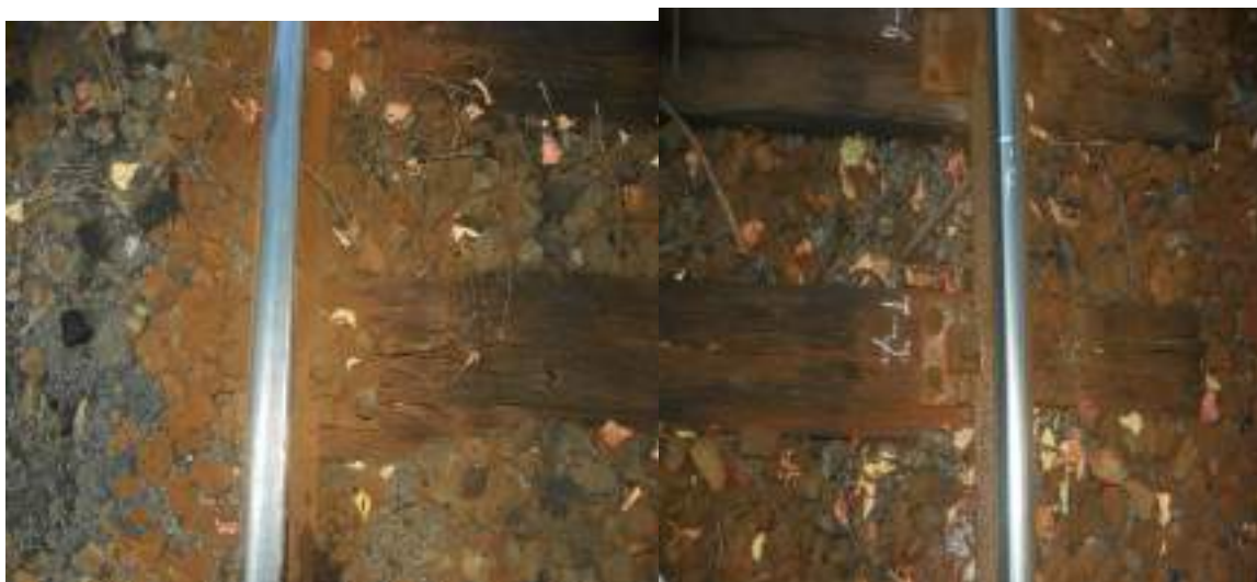
Foto.nr.11 - Traversa T-7
