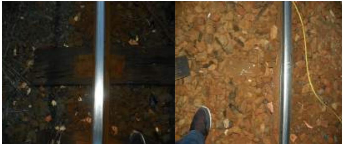
Foto.nr.9 - Traversa T_2
