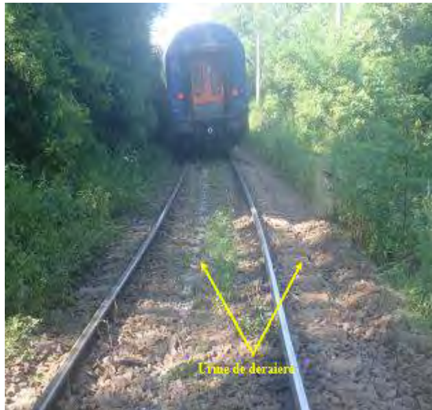
Foto nr.11- Urme de deraiere
