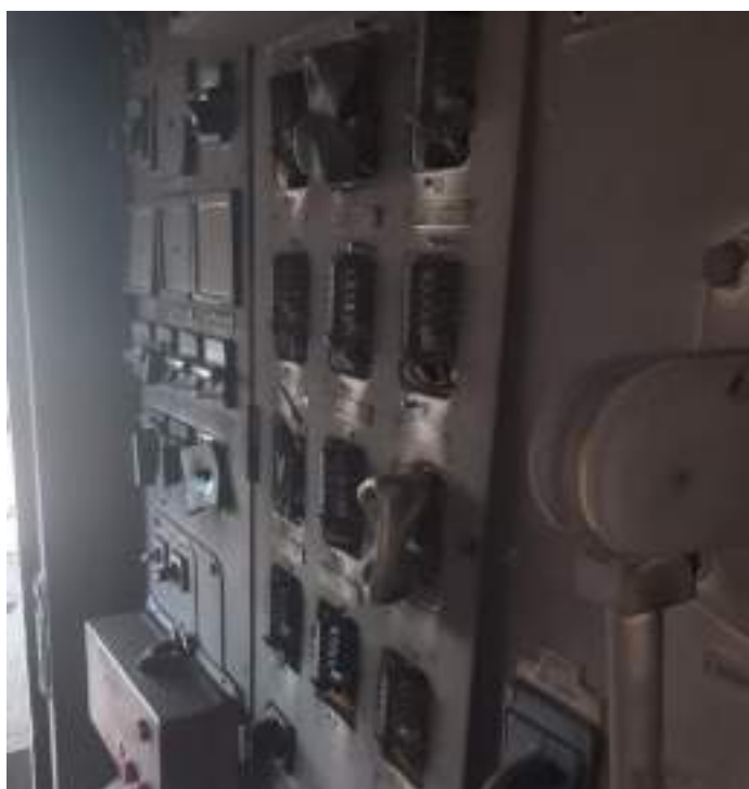
Foto nr.2. Blocul de aparate cu elementele din material plastic deformat
