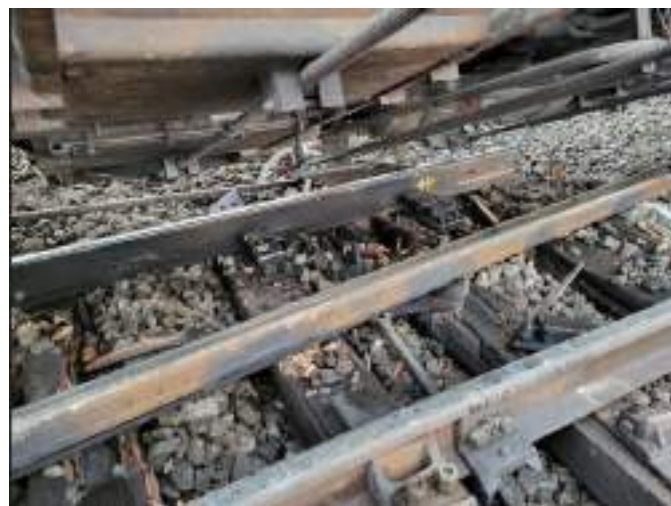
Foto nr.7 și 8. Schimbătorul de cale nr.16 afectat de deraiere
