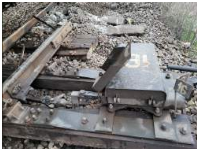
Foto nr.7 și 8. Schimbătorul de cale nr.16 afectat de deraiere
