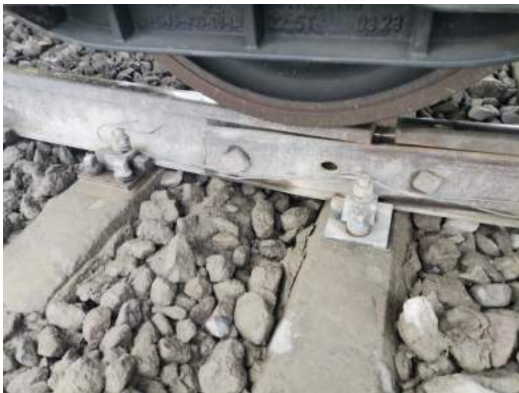
Foto nr.10. Prisma de piatră colmatată cu noroi în zona joantei
