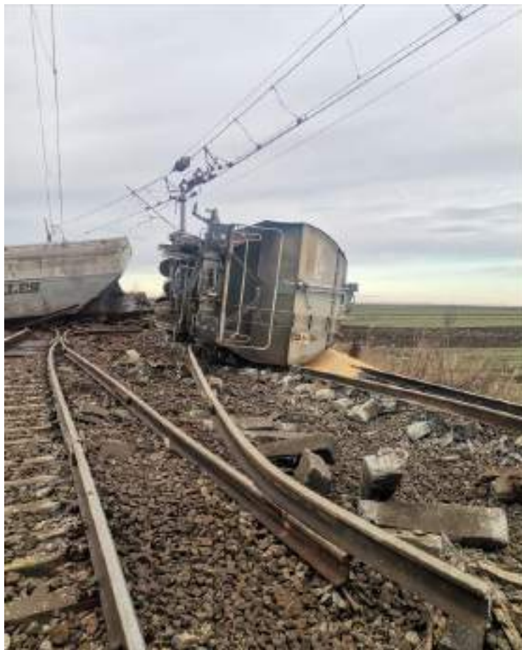
Foto nr.9. Diagonala 2/4 afectată de deraiere
