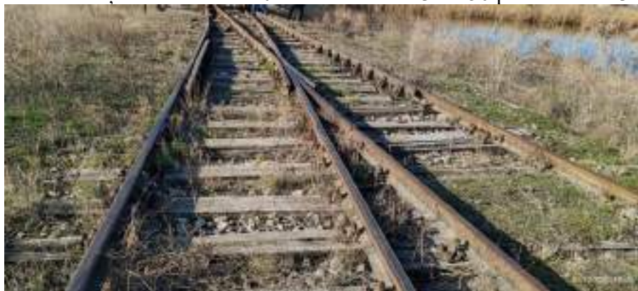
Foto nr. 1 – locul producerii accidentului
