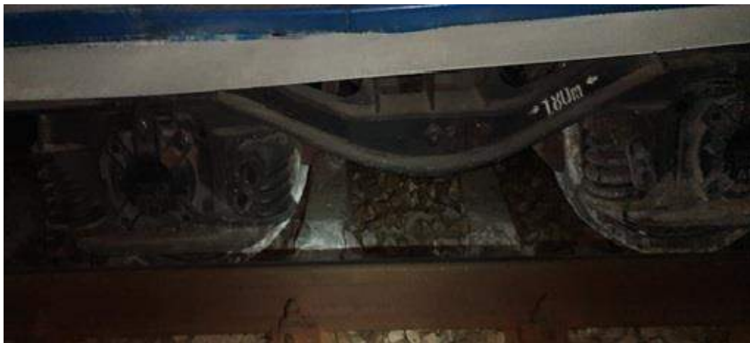
Foto nr. 8 – Boghiul nr.1 deraiat la km 75+950
