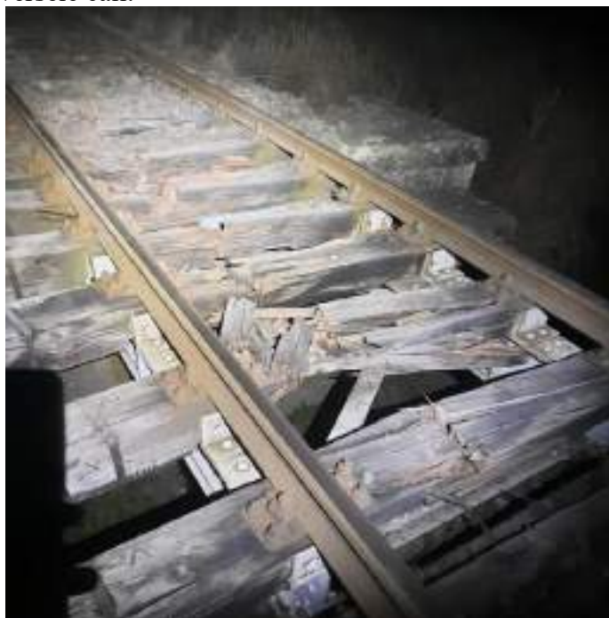
Foto nr. 7 – Traversele podeșul feroviar de la km76+580
