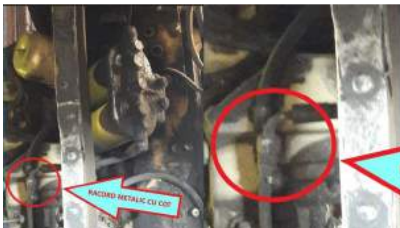
Imaginea nr.7 – cotul de 90° de la racordul metalic al furtunului de intrare (desen de la fabricantul Tedom)
