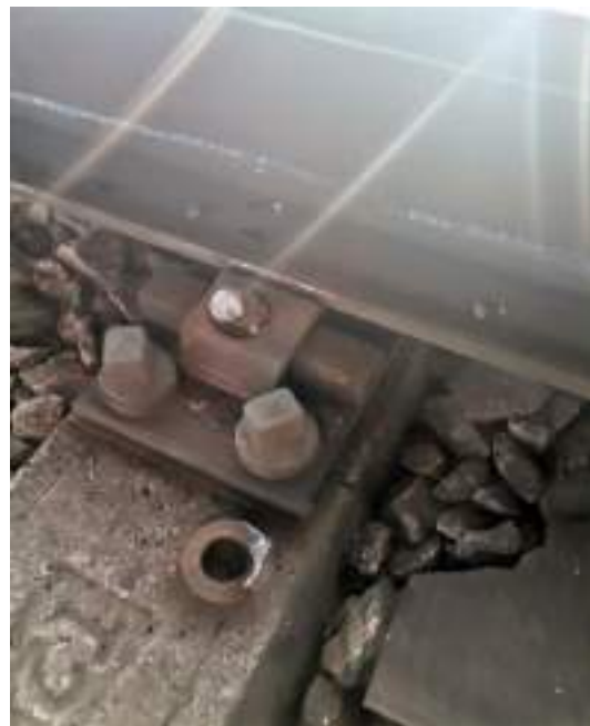
Foto nr.12 – talpa șinei scoasă din rebordul plăcii Foto nr.13 – șina înclinată spre exteriorul căii
