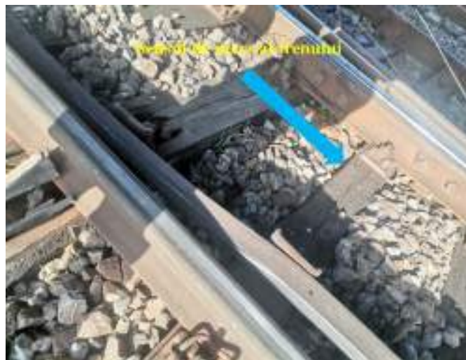
Foto nr. 14 – contrașina deformată a inimii de încrucișare a schimbătorului de cale nr.1
