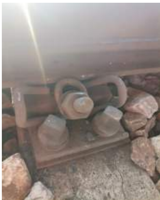
Foto nr.12 – talpa șinei scoasă din rebordul plăcii Foto nr.13 – șina înclinată spre exteriorul căii
