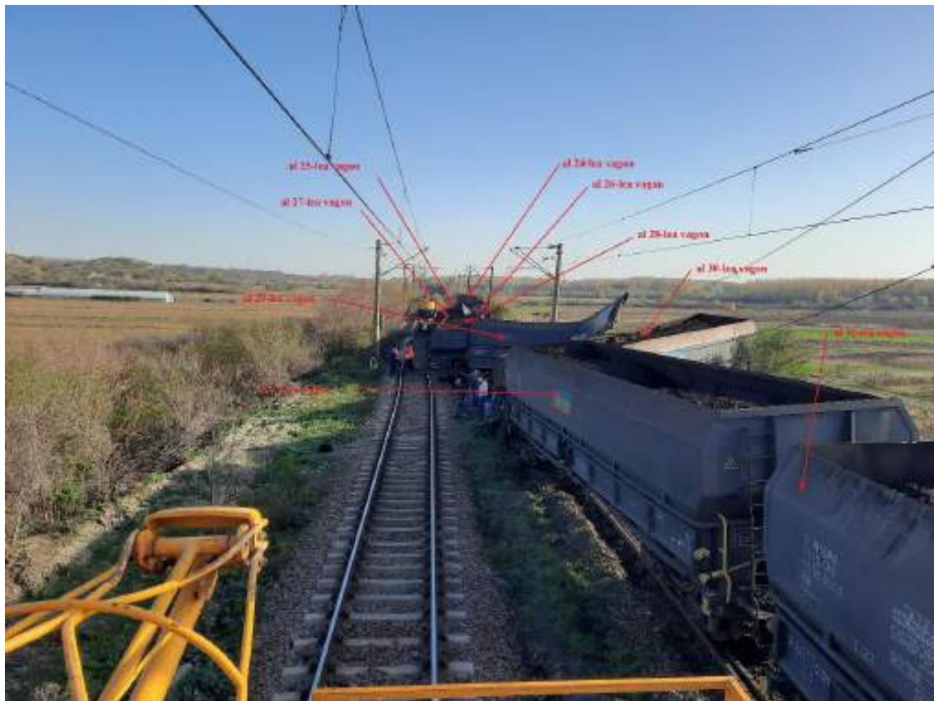
Foto nr.2 – poziția vagoanelor deraiate
