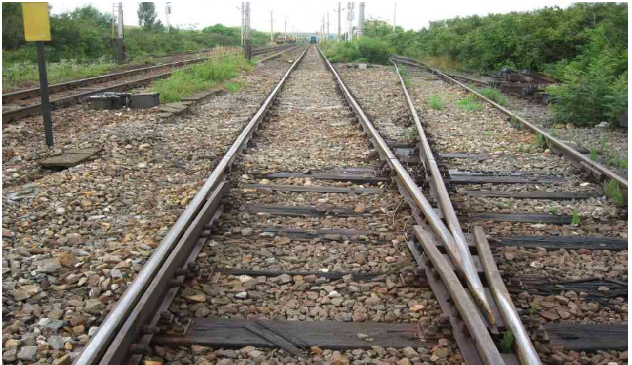
Figura 7 STAREA TRAVERSELOR IN ZONA INIMII
